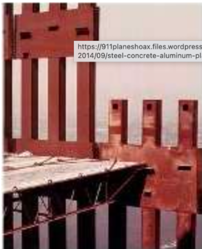
Фотография во время строительства башен-близнецов - стальная конструкция внешней обшивки
